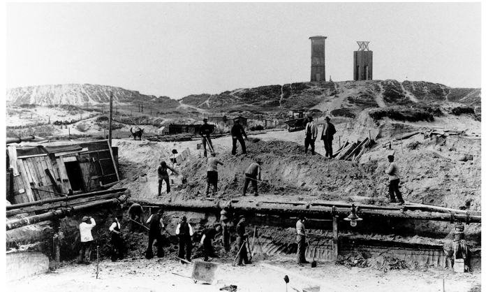
Bau des Wasserturms 1929, Stadtarchiv Norderney.
